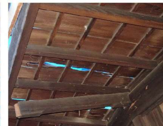
座敷棟の縁側の化粧屋根裏（細部）
