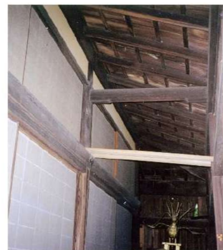
座敷棟縁側（解体前）
