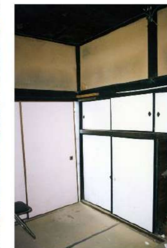
座敷棟の六畳（解体前 押入）
