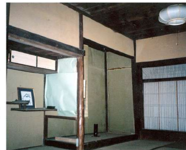
座敷棟の十畳の座敷飾り（解体前 床の間・棚・付書院等）
