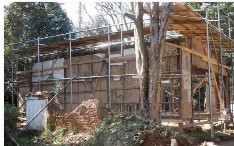
座敷棟（解体後の状況、前方には崩れた土塀が見える）
