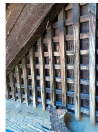
座敷棟の破風等（細部）
